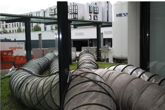
**Abbildung 6 Heißluftgebläse werden in den Keller geführt**
