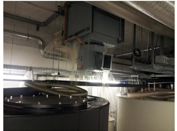
Abbildung 3 Wassereinbruch an einem Lüftungsschacht
