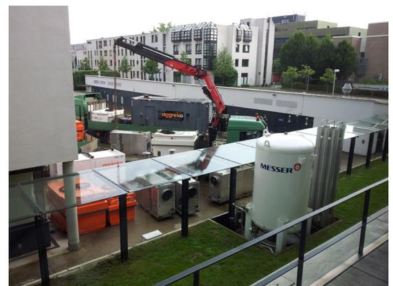
Abbildung 4 Aufbau von Notstromversorgung und Heißluftgeläsen im Innenhof
